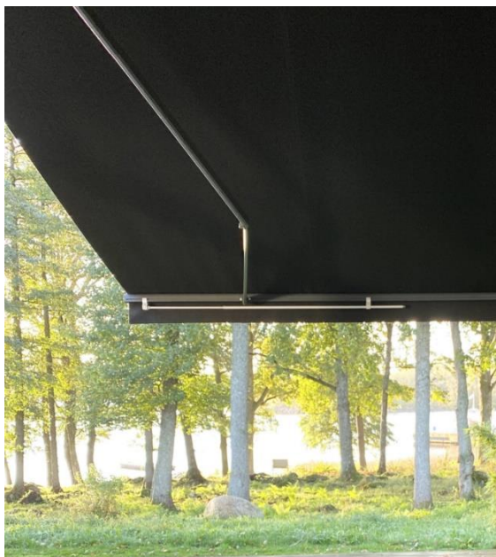
Vindstag, uppfällda i viloläge mot frontprofilen.
